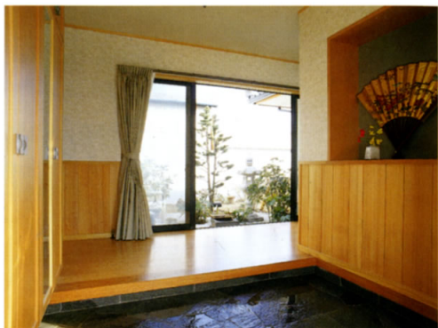
玄関ホール 正面に中庭を望み、来訪者に安らぎを与えるゆったりとした造りの玄関ホール。床は磁器質タイルの乱張りで、玄関収納は大きな飾り棚を兼ねた造り付け。
